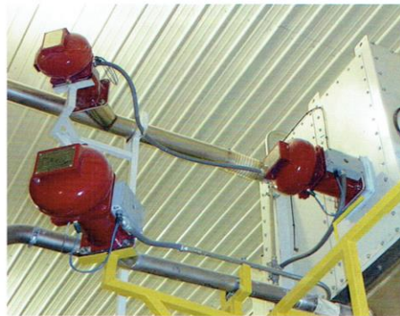
Die Entkopplungssysteme (links) verhindern, dass eine Flammenfront sich in Rohren ausbreitet
