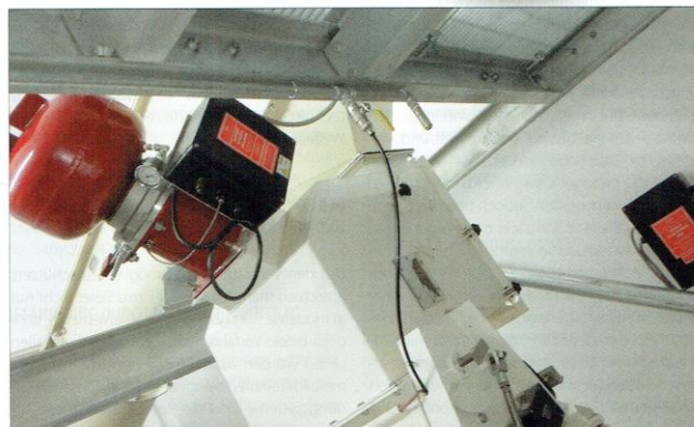
Das System kann in jeder beliebigen Lage eingebaut werden und eignet sich auch für ungünstige Platzverhältnisse
