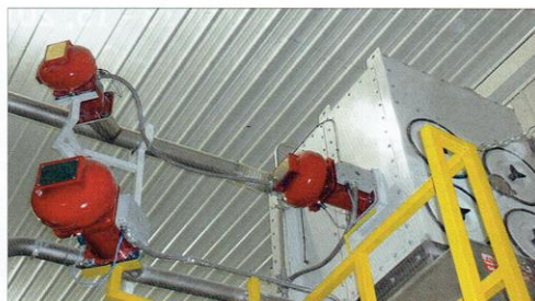
Die beiden Entkopplungssysteme links im Bild verhindern, dass eine Flammenfront sich im Rohrsystem ausbreitet. Das dritte, baugleiche Teil rechts erstreckt – als Unterdrückungssystem verbaut – eine mögliche Explosion im Prozessbehälter bereits in der Entstehung
