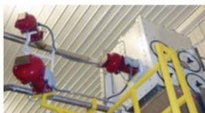
Abb. 2: Zwei IPD-Systeme verhindern, dass eine Flammenfront sich im Rohrsystem ausbreitet (links). Ein drittes, baugleiches Teil erstickt – als Unterdrückungssystem verbaut – eine mögliche Explosion im Prozessbehälter bereits in der Entstehung (rechts).
